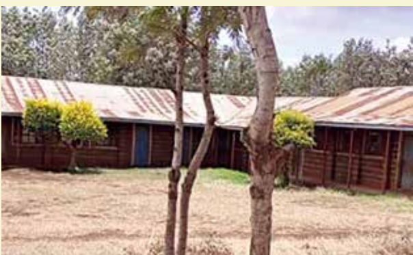
La nuova area del Centro Sanitario in costruzione.
